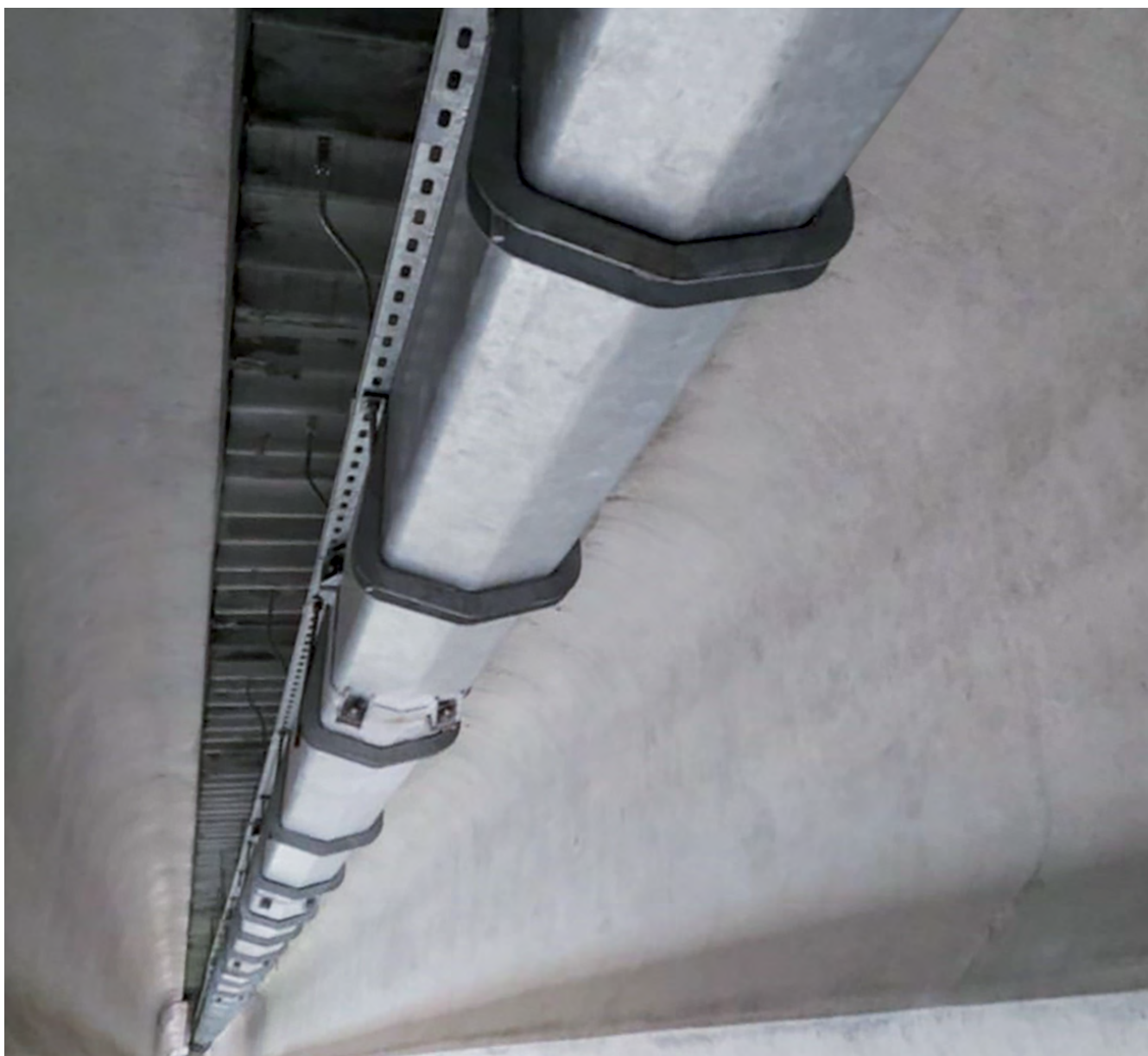
г. Москва, путепровод ЦКАД
