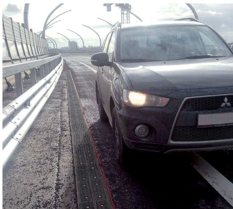
ЛВМ Bridge-Light, г. Санкт-Петербург, Западный скоростной диаметр (ЗСД)
