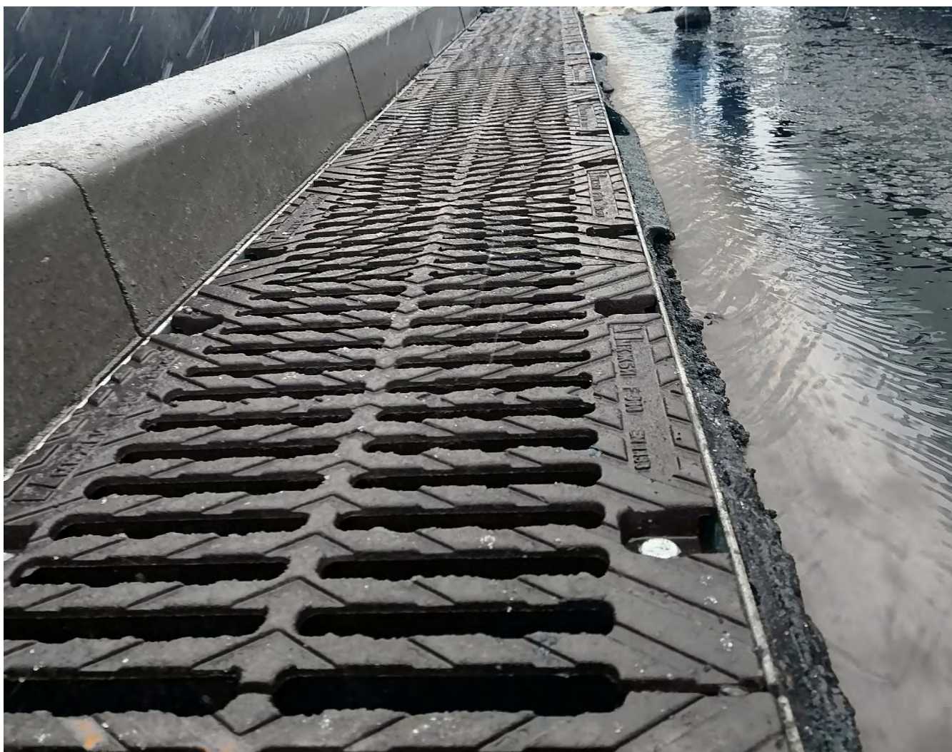
ЛВМ Brige. Транспортная развязка автомобильной дороги «ЗСД» в районе Шкиперского протока.
